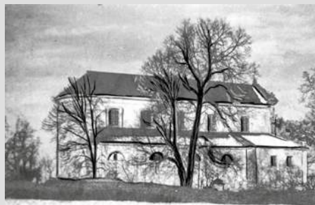
Общий вид с боковой стороны
